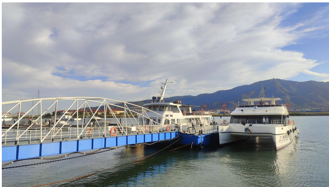
图 2.1-1b 项目现状建设情况图
