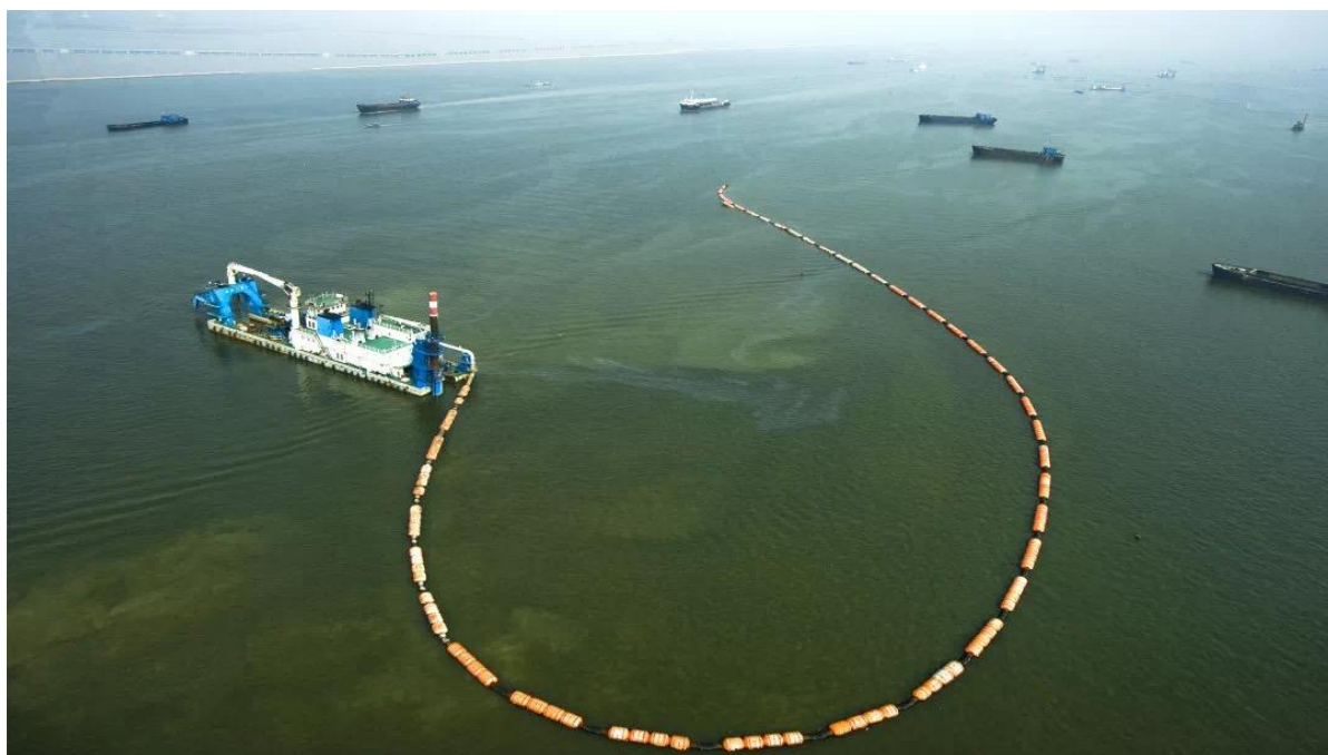
图 1.5-1 绞吸挖泥船施工作业示意图
