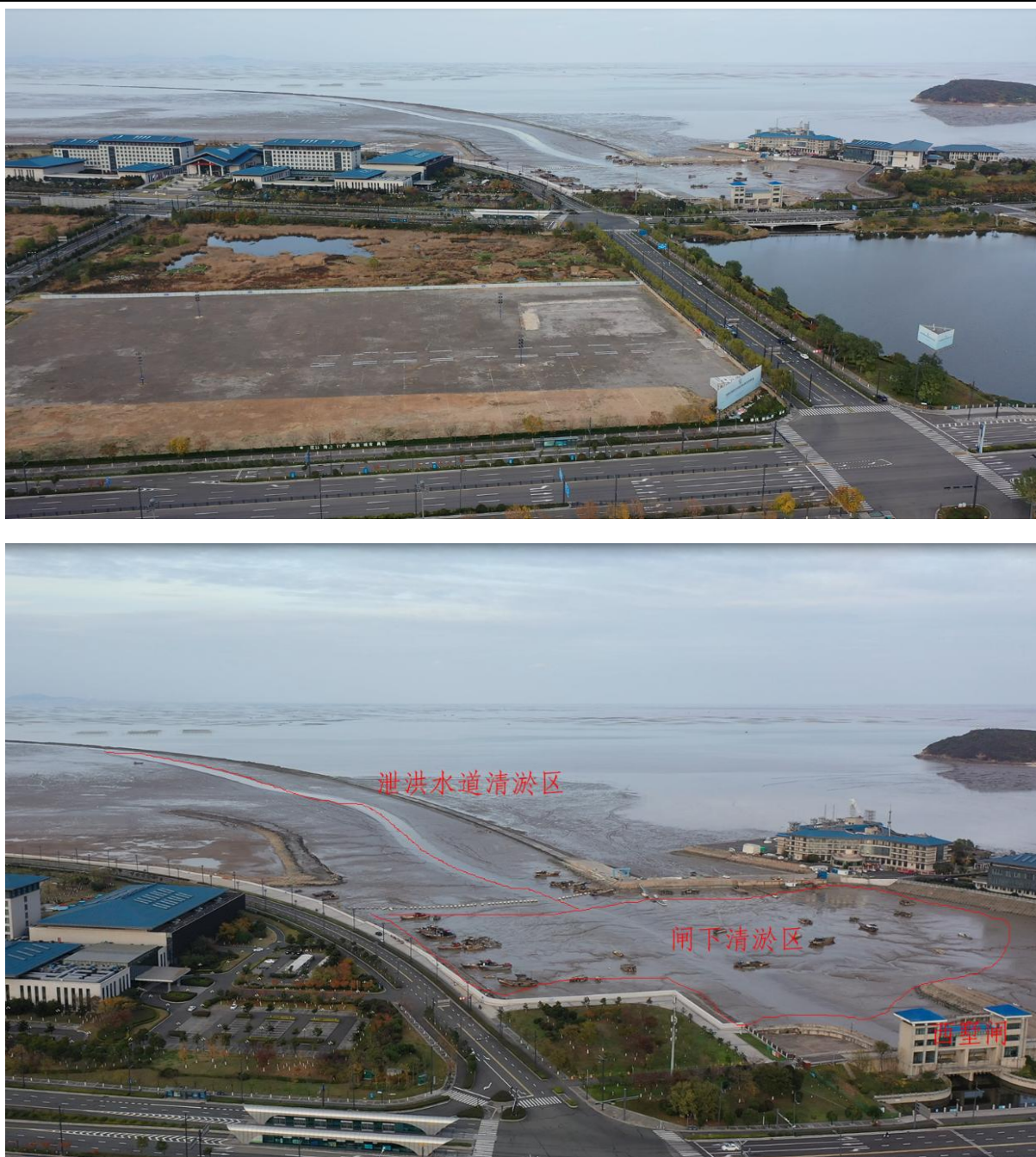
图 4.1-1 工程区现状照片
