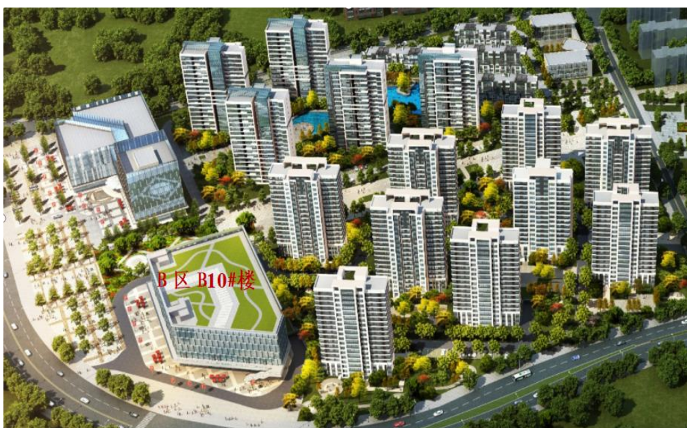
（图 1-新海岸·熙墅湾住宅小区建设项目鸟瞰图）
